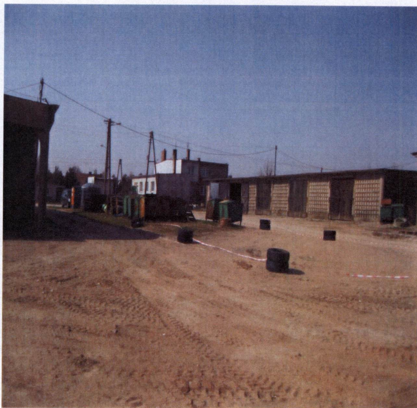
Fot. 4 Budynek przeznaczony do rewitalizacji
