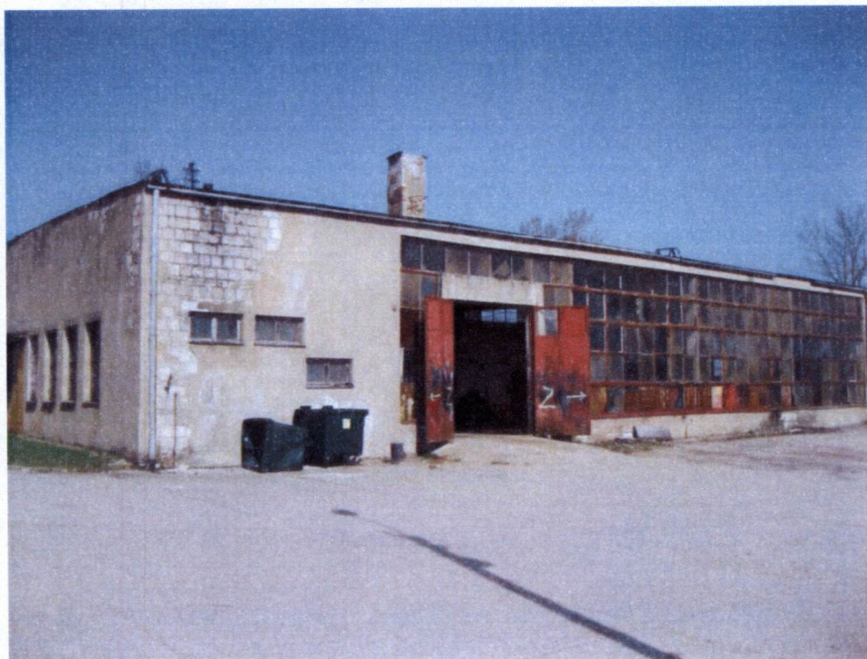
Fot. 3 Budynek przeznaczony do rewitalizacji
